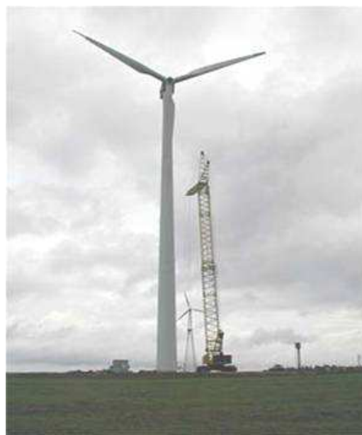
Рис. 17. Вторая промышленная ВЭУ мощностью 600 кВт в процессе монтажа 2002 г.
