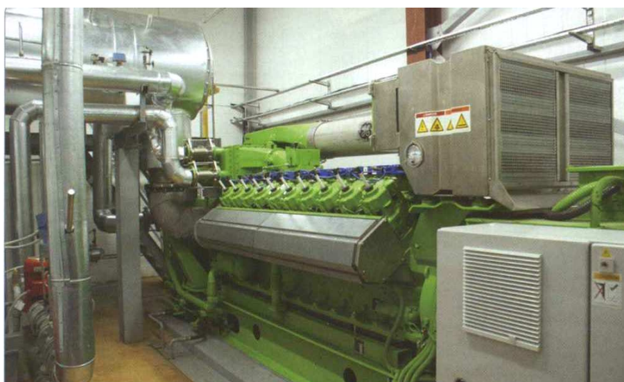
Рис. 58. Газомоторная поршневая установка в ОАО «Керамика»
